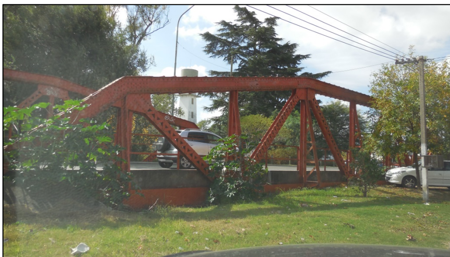
Figura 12.- Obstrucción del escurrimiento natural bajo el puente
